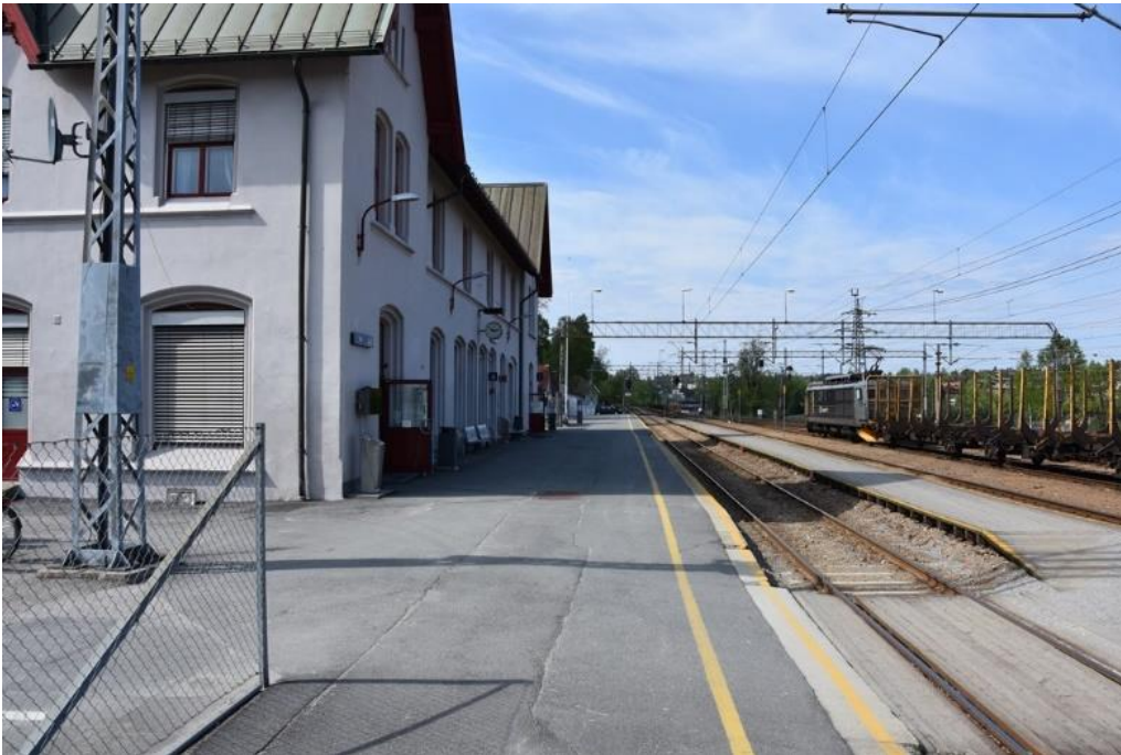
Figur 6-6: Sarpsborg stasjon. Smal mellomplattform. Foto: Network Statement
