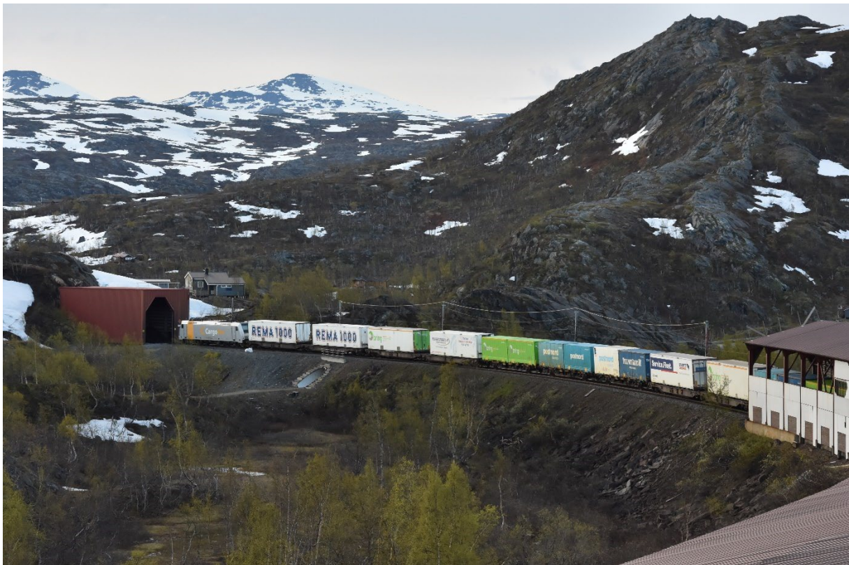
Illustrasjon 1 Bilde fra Ofotbanen med et godstog som er viktig i vareforsyningen for Nord-Norge. Bildet illustrerer både tunnel, snøoverbygg og høy fylling. Foto: Njål Svingheim, Jernbanedirektoratet
